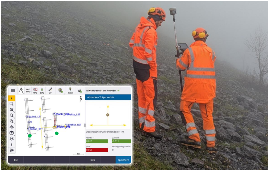
Abbildung 5 Neue Prozesse zur Synchronisation zwischen GNSS-Geräten und Visualisierung des Baufortschrittes
